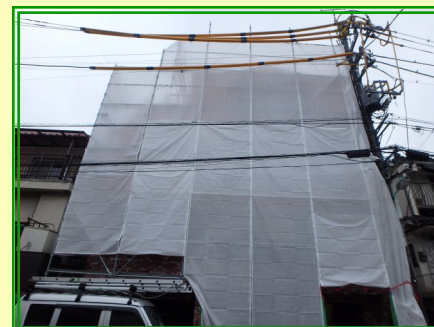
電線防護管を設置した現場
