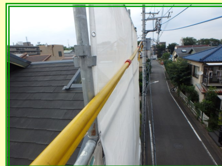
電線防護管を設置した現場
